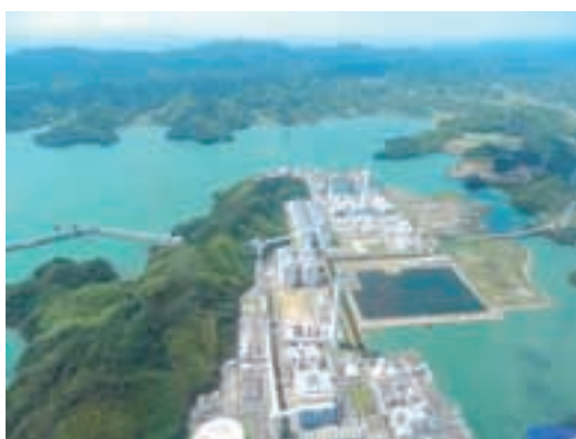
『橘湾火力発電所』
