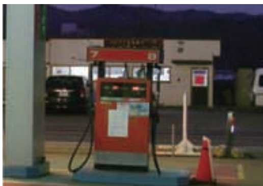
写真14 地震により傾いた固定給油設備
