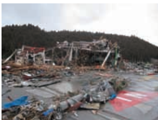
写真23 瓦礫に埋もれる給油取扱所 6)
