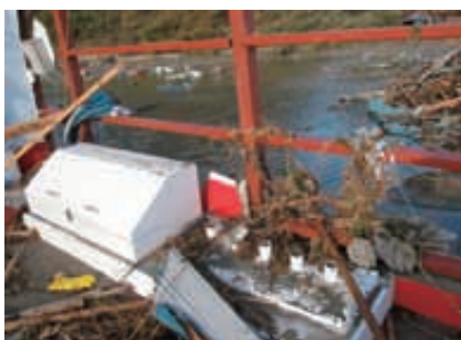
写真21 カバーが設置された注入口 1 6)
