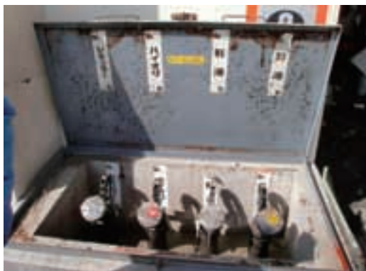
写真22 カバーが設置された注入口 2 6)
