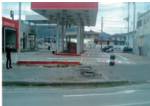
写真8 給油取扱所外観
