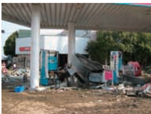
写真13 損傷した固定給油設備 6)
