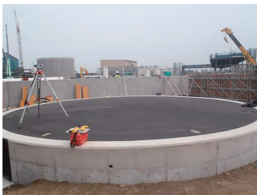
写真3 基礎表面のアスファルトサンド
