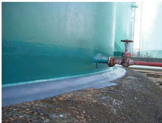
写真4 底部板外面張出し部の雨水浸入防止措置
