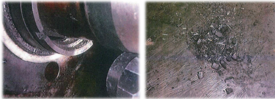
劣化したＯリングの残骸
