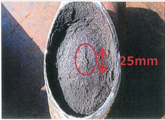
サポート切断後の配管エルボ(外面)
