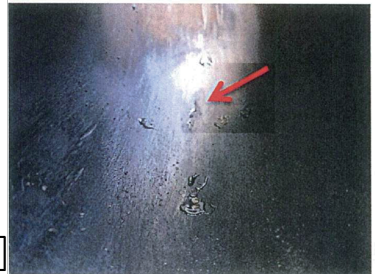
配管エルボ(内面)
