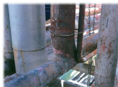
開孔した配管とダミーパイプサポート 設置状況
