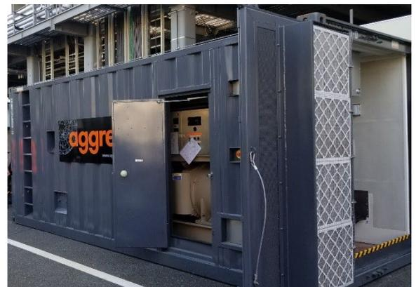
写真1 コンテナ型発電機（1500KVA）
