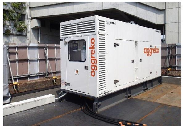
写真2 キャノピー型発電機（320KVA）
