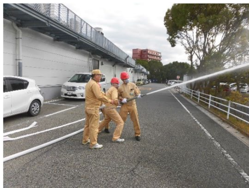
屋外消火栓実放水状況
