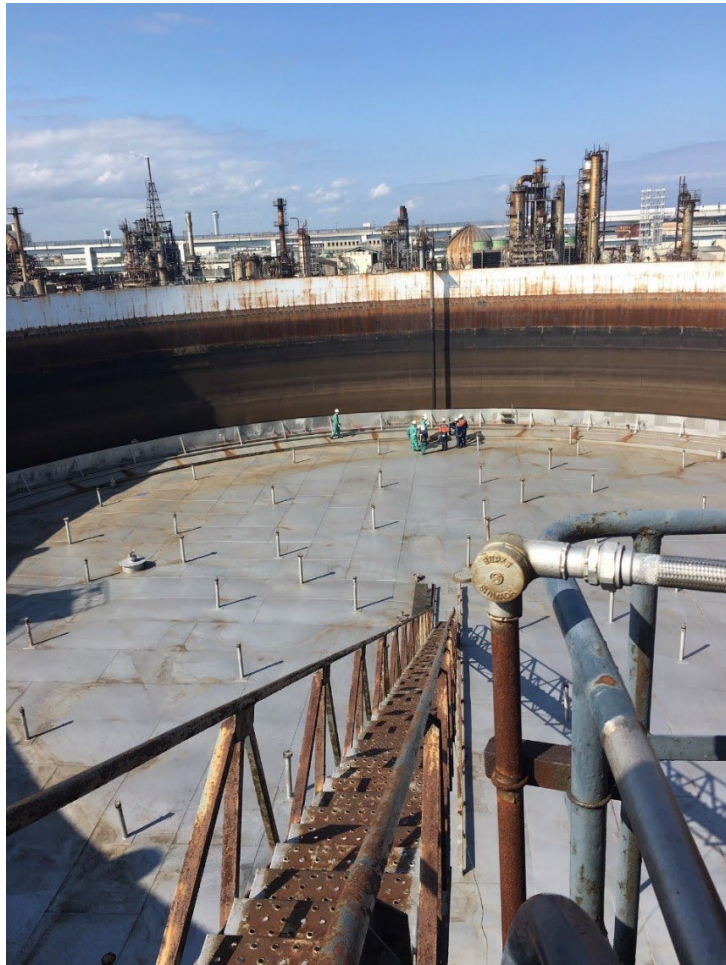
図3-1 浮き屋根の現地調査風景
