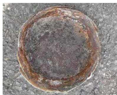
(写真15) 東側通気管引火防止網内側
