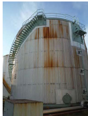
(写真4) タンク本体東側
