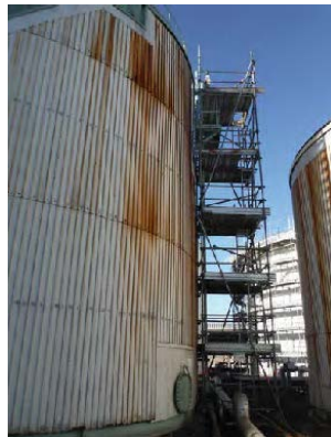
(写真6) 開口部の確保作業全景
