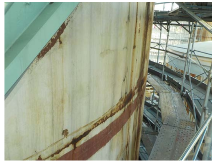
(写真11) 東側階段付近
