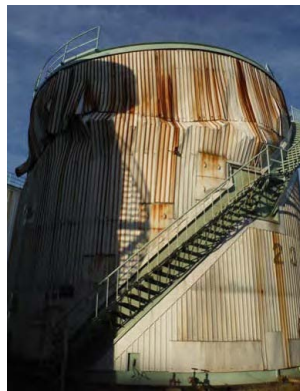
(写真3) タンク本体南側
