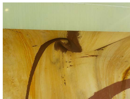
(写真9) 西側トップアングル付近変形
