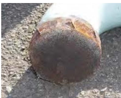
(写真14) 東側通気管引火防止網外側
