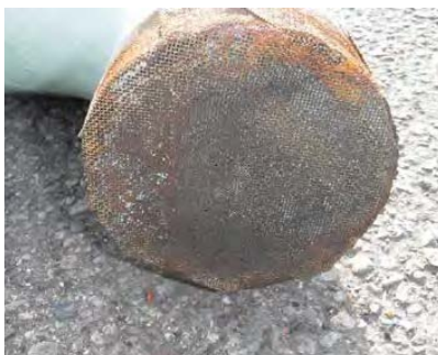
(写真12) 西側通気管引火防止網外側
