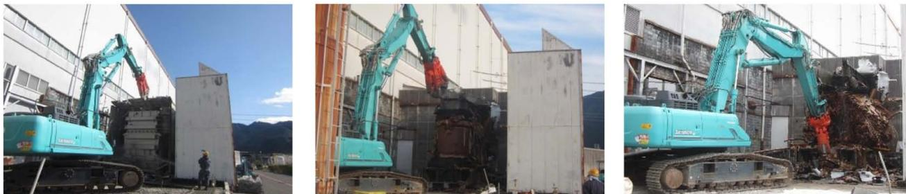
写真3 主要変圧器の破碎作業
