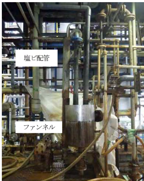
写真4. ファンネル部の状況
