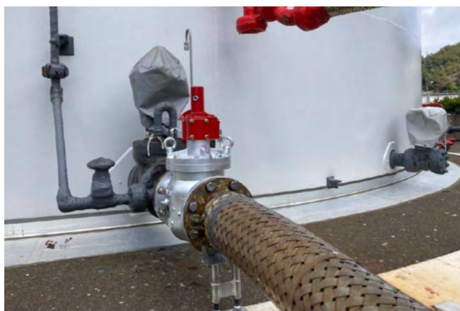
図.8 東京電力パワーグリッド株式会社 父島内火力発電所900kL A重油タンクへの150A 浸感弁設置
