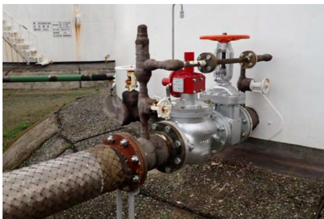
図.7 日米ユナイテッド株式会社屋久島油槽所260kL ガソリンタンクへの150A 浸感弁設置
