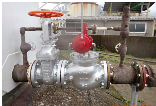
図.7 日米ユナイテッド株式会社屋久島油槽所260kL ガソリンタンクへの150A 浸感弁設置
