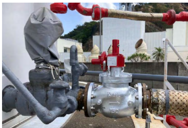
図.8 東京電力パワーグリッド株式会社 父島内火力発電所900kL A重油タンクへの150A 浸感弁設置
