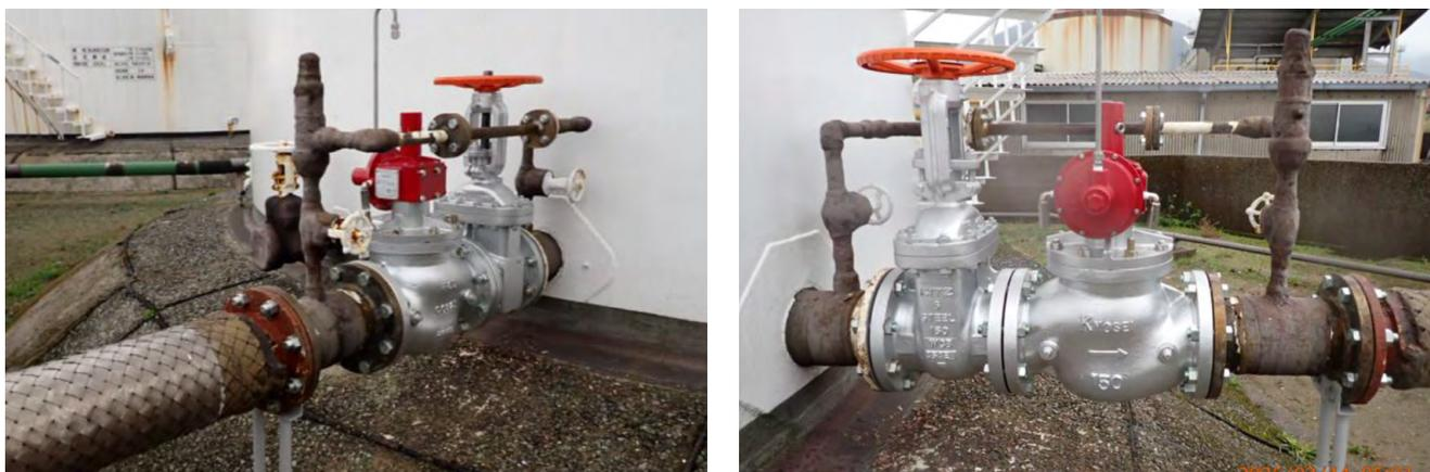
図.7 日米ユナイテッド株式会社屋久島油槽所260kL ガソリンタンクへの150A 浸感弁設置
