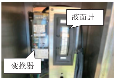
写真 1 注油ボックス内の状況
