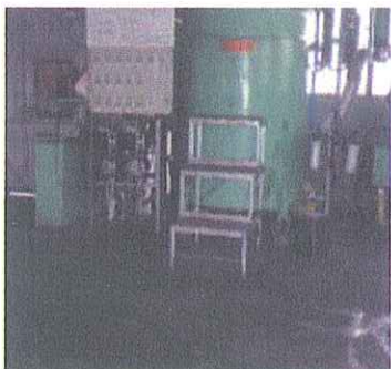
写真5 散水した接着剤工場
