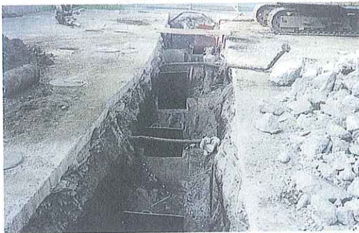
同上 給油取扱所開口、施工状況
