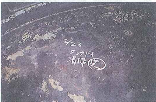
30,000 ℓ 屋外タンク貯蔵所（設置後20年） 清掃完了
