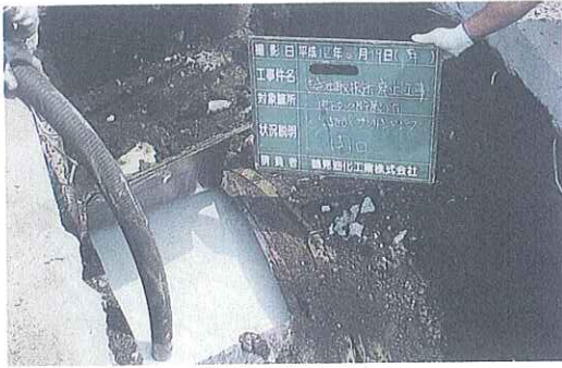
9,500ℓ閉塞型ガソリタンク 施工状況
