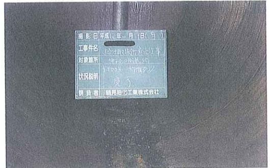
同上 清掃完了
