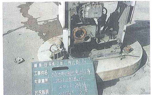
給油機分解・通水等施工状況
