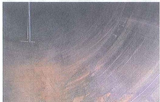
同上 施工完了
