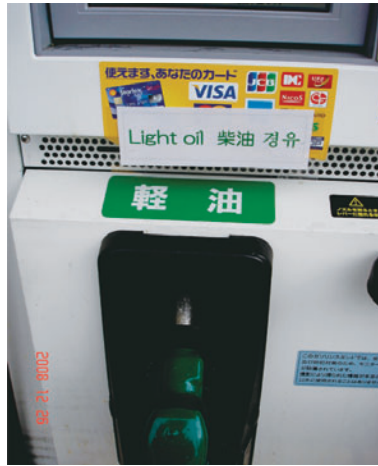
軽油の危険物標示板
