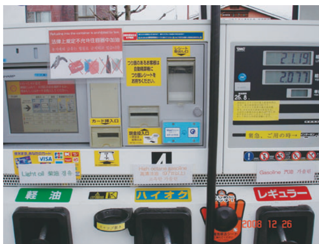
セルフガソリンスタンド固定給油設備に外国人用の危険物標示板を取り付けた状況
