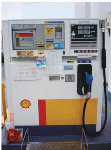
セルフガソリンスタンド固定注油設備に外国人用の危険物標示板を取り付けた状況
