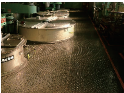
写真7 コンクリート床面への水散布状況と鉄板敷きの状態
