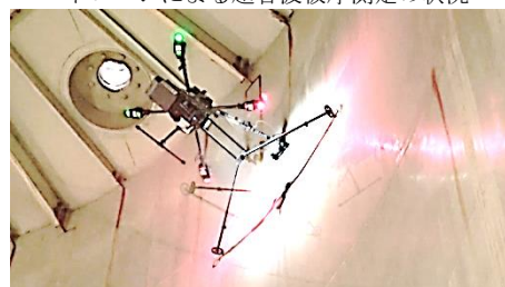
ドローンによる超音波板厚測定状況
