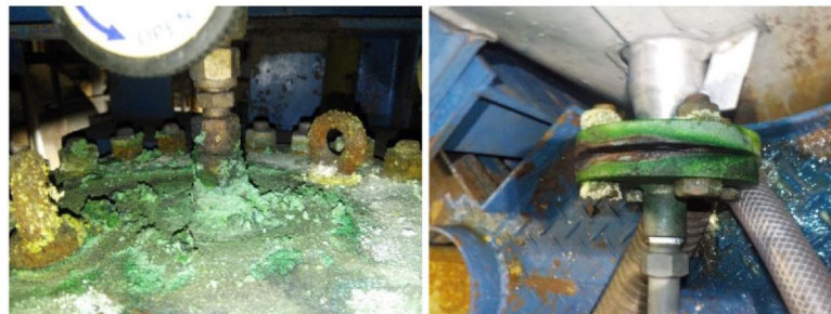
写真8-3-2 フッ化水素の漏えい痕（金属の腐食による結晶物）
