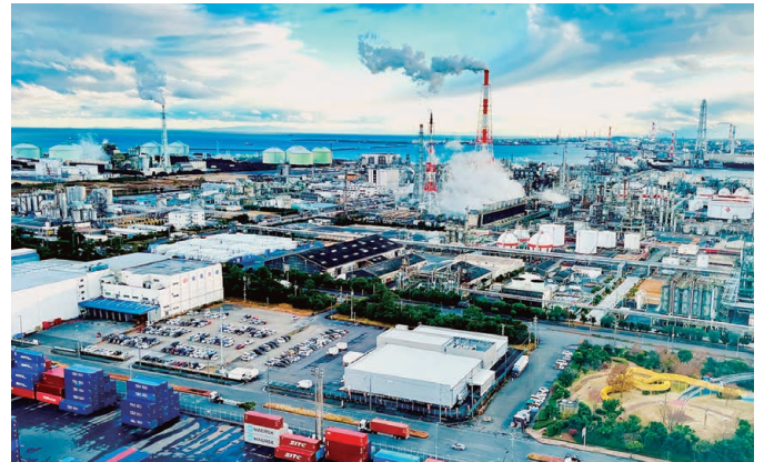
第3コンビナートの状況（四日市港ポートビルから撮影）
