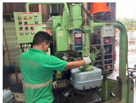
写真3 製造ラインの確認 (タンク上下のシーム溶接)
