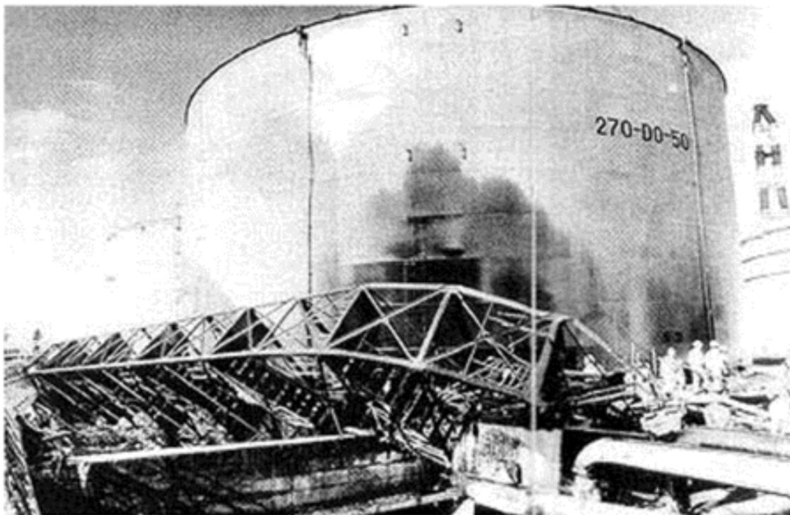
写真 漏えいのあったタンクと倒壊した直立階段（消防庁資料より）
