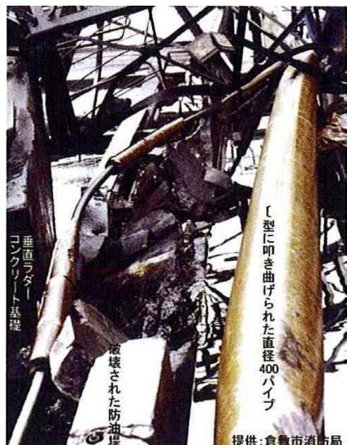
図8 独立階段の衝突による防油堤及び
