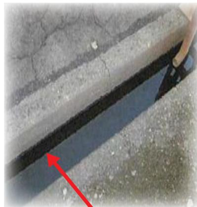
原油タンク側溝への原油の漏えい状況
