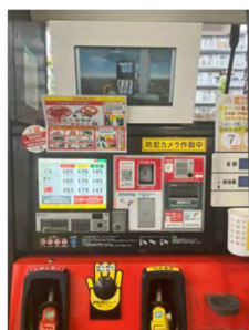
固定給油設備の操作パネル
