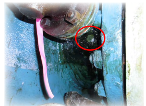
治具の埋め込み状況
