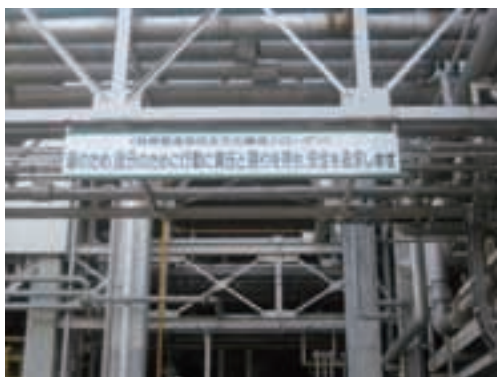
写真3 スローガンの現場掲示
